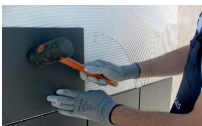
Assentamento com auxílio do maço de borracha
