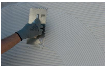
Regularização com talocha denteada
