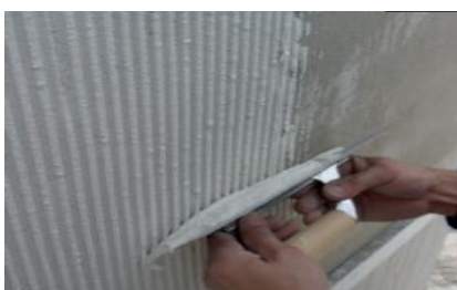
Espalhamento de ADHERE Flex Basic
