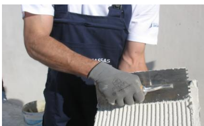
Espalhamento do ADHERE Multiflex no tardo do cerâmico a colar
