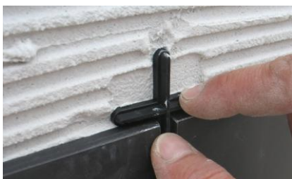
Colocação de cruzetas
