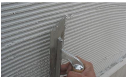
Barramento sobre suporte com talocha denteada
