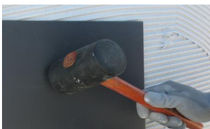
Assentamento com auxílio do maço de borracha
