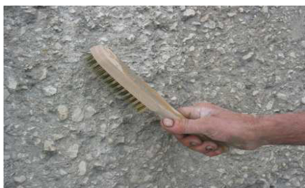
Remoção das matérias desagregadas
