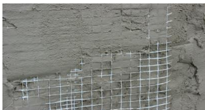
Embebimento da rede de reforço
