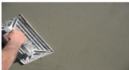
Talochamento da superfície final
