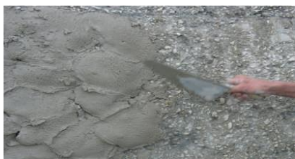
Camada de consolidação.
