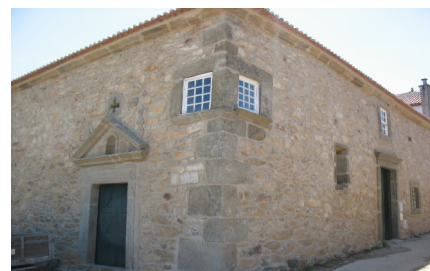
Aspecto final da argamassa
