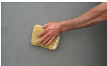
Execução do acabamento areado
