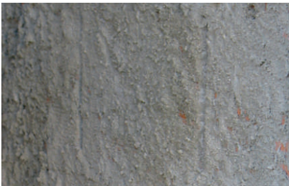
Suporte com Argamassa de Chapisco
