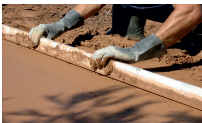
Regularização com régua metálica
