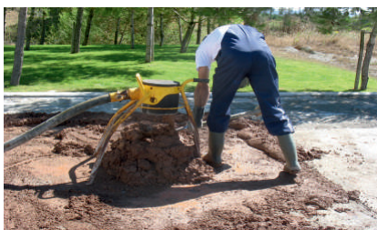
Colocação da argamassa
