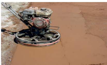
Talochamento da superfície com meio mecânicos
